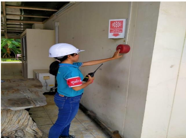
จป.วิชาชีพ กดFire Alarm
