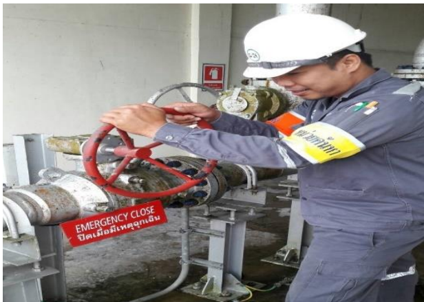
ปิดวาล์วแก๊สที่ Metering เสร็จแจ้งกลับหัวหน้างาน
