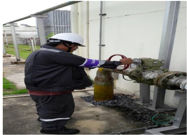
ปิดวาล์วแก๊สหลัง Bay12 เสร็จแจ้งกลับหัวหน้างาน
